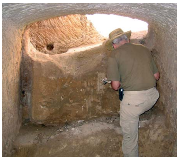
Foto 2: Punt on l'excavació de l'escala meridional del Primer Nivell talla incorrectament —vora el sostre— una galeria (punt c de la topografia), cosa que suposam que va obligar a canviar-ne la traça. A l'enfront hi veim la marca d'extracció d'un cantó i les regates verticals per arrabassar-los. Foto J. Florit.
