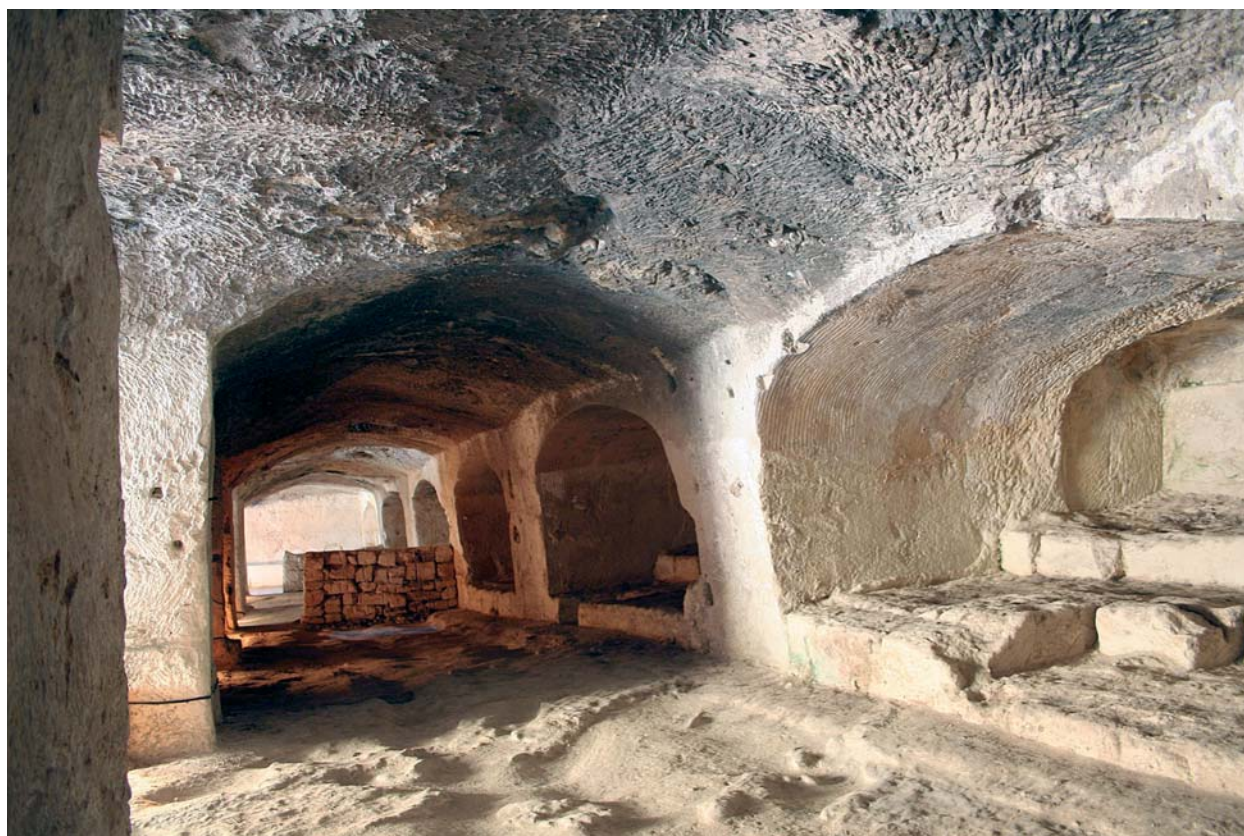
Foto 6: "Capelles" d'extracció de cantons i d'ampliació d'una sala a les Quadres. Foto J. Florit.
